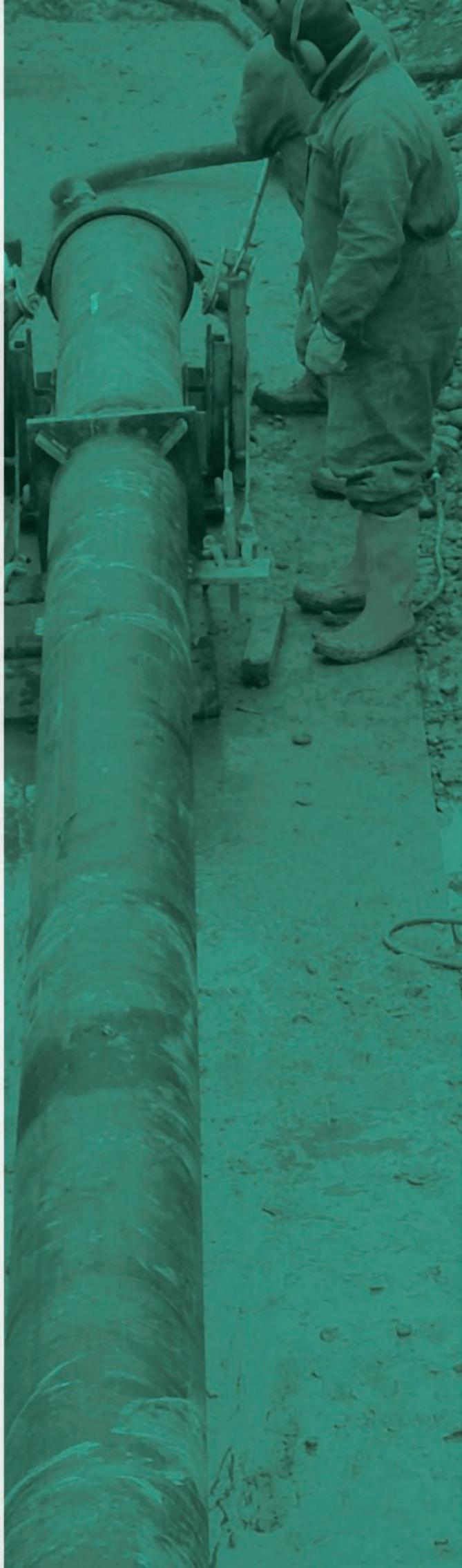
LA TECNOLOGIA PERMETTE DI INFIGGERE NEL TERRENO CONDOTTE DI ACCIAIO A FRONTE APERTO CON IMPIEGO DI SPECIALI PERCUSSORI PNEUMATICI CON L'APPLICAZIONE DI UNA SOLLECITAZIONE IMPULSIVA (E NON UNA SPINTA CONTINUA).
