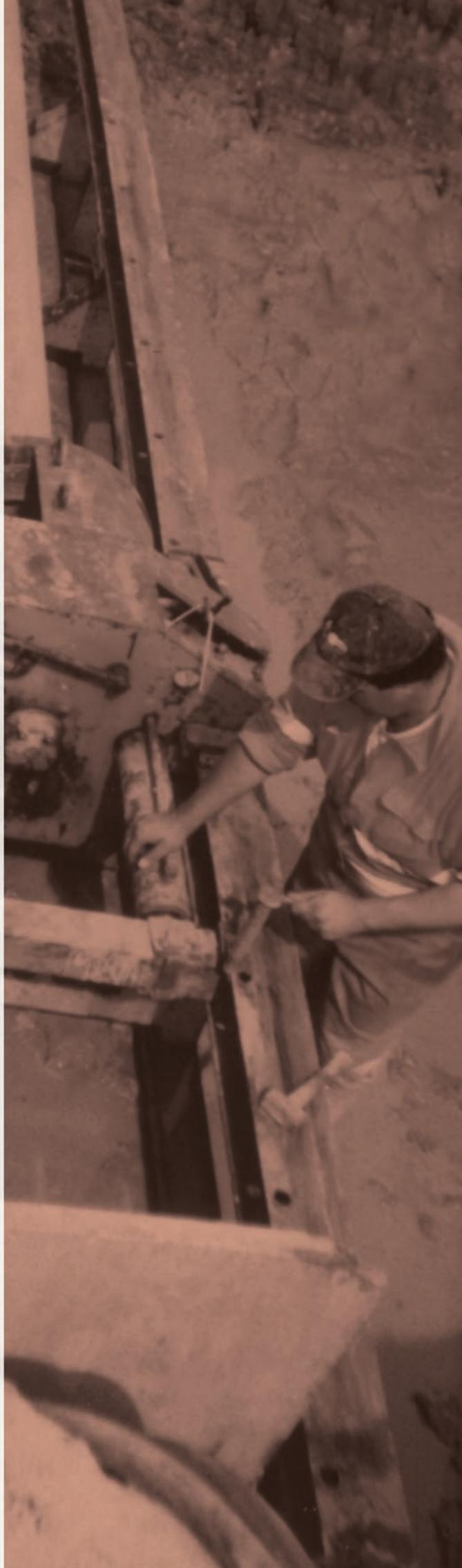
LA TECNICA DI SCAVO CHE UTILIZZA UNA PRESSOTRIVELLA PER L'ESECUZIONE DEL FORO È SOSTANZIALMENTE ASSIMILABILE ALLO SPINGITUBO.
