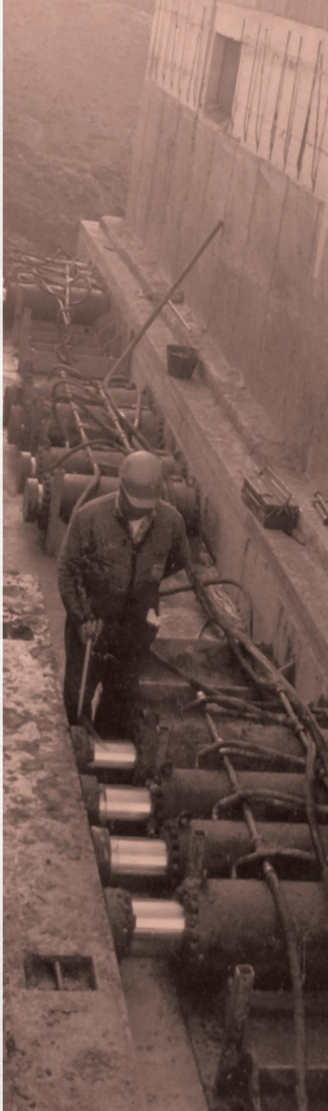
QUESTA CATEGORIA DI INTERVENTI CONSISTE NEL RICORSO A MARTINETTI IDRAULICI IN TUTTI I CASI IN CUI È NECESSARIO RICOLLOCARE MOMENTANEAMENTE O IN VIA DEFINITIVA UNA STRUTTURA (O PARTE DI ESSA) PER MOTIVI DI MANUTENZIONE E/O RISISTEMAZIONE.
