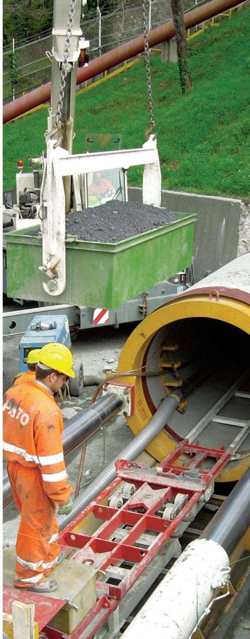
LA TECNICA CONSISTE NELLA REALIZZAZIONE DI MICRO-GALLERIE RETTILINEE DI DIAMETRO COMPRESO FRA I 100 mm ED I 3000 mm TRAMITE L'INFISSIONE A SPINTA NEL TERRENO DI UNA TUBAZIONE (ACCIAIO, C.A., GRES, PRFV, POLYCRETE) A FRONTE APERTO E CONTEMPORANEO SCAVO.
