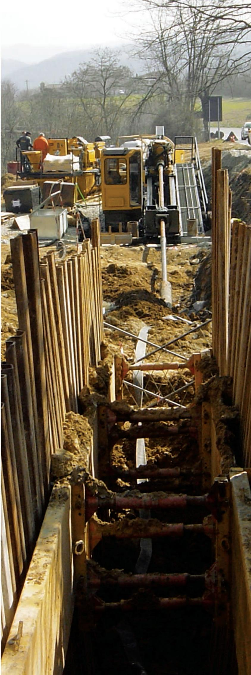
LA TRIVELLAZIONE ORIZZONTALE CONTROLLATA (T.O.C.) O HORIZONTAL DIRECTIONAL DRILLING (H.D.D.) È UNA TECNICA DI TRIVELLAZIONE CON CONTROLLO ATTIVO DELLA TRAIETTORIA PER LA POSA DI CONDOTTE SENZA SCAVO.
