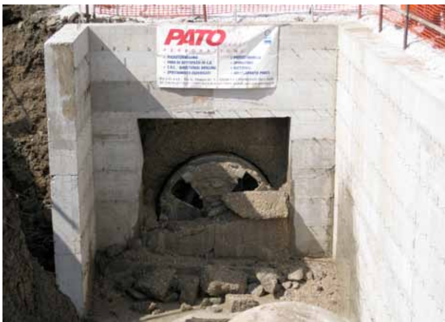
Figura 5 - Uscita microtunnel S2
