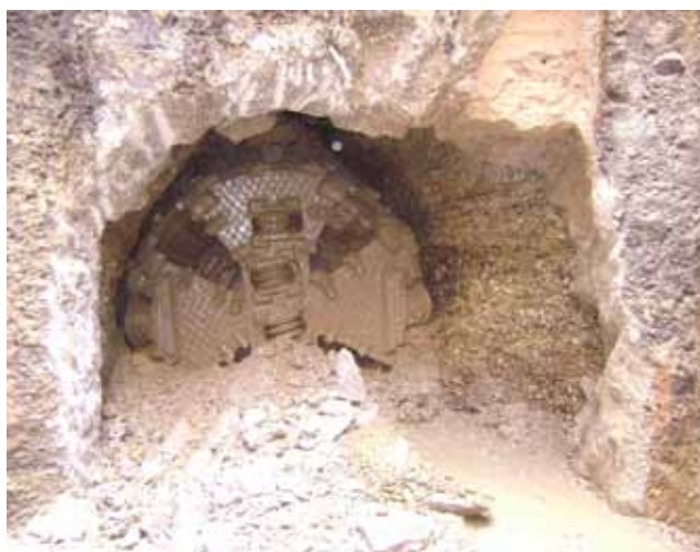
Figura 4 - Uscita microtunnel S1
