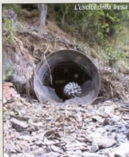
Il microtunnel realizzato
